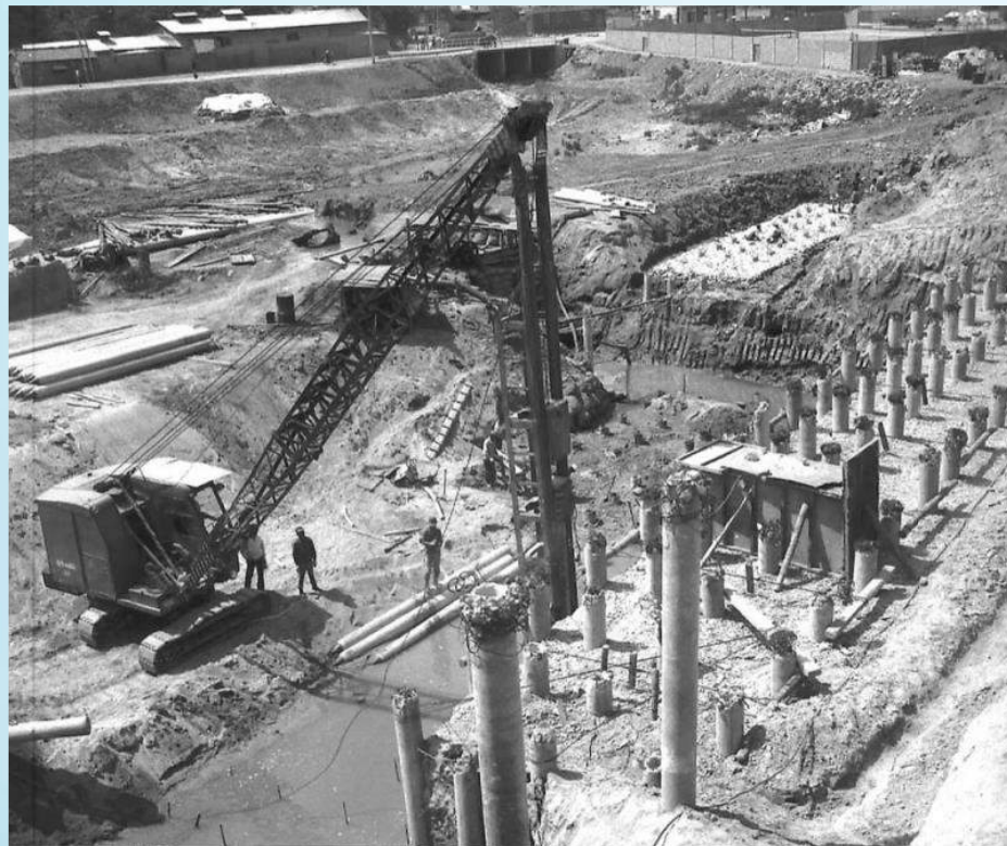
<'70.6월 착공 청계천하수처리장 공사현장>
