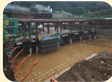
신림공영차고지(공사중) 저류조 담수 후
