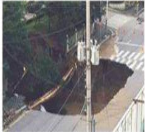
○ 낮은 수도관 누수로 인한 토사 유실과 함께 지반침하 발생(20.8.26, 구리)
