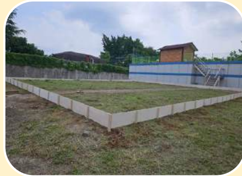
배수지(수도시설) 담수준비 (물막이설치)
