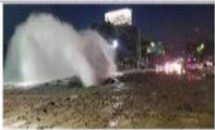
○ 낮은 수도관 누수로 인한 토사 유실과 함께 지반침하 발생(20.8.26, 구리)
