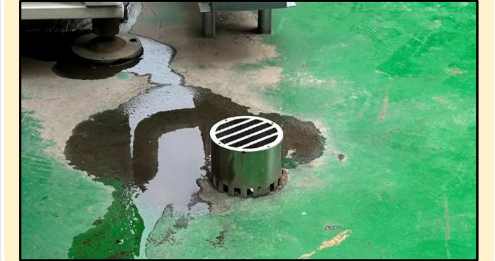
배수홈통 설치 사진
