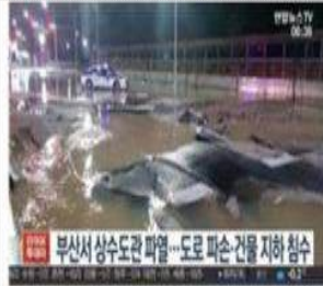
○ 노후상수도관 파열로 도로 균열, 인근 지하 주차장 침수 (20.2.7, 부산)
