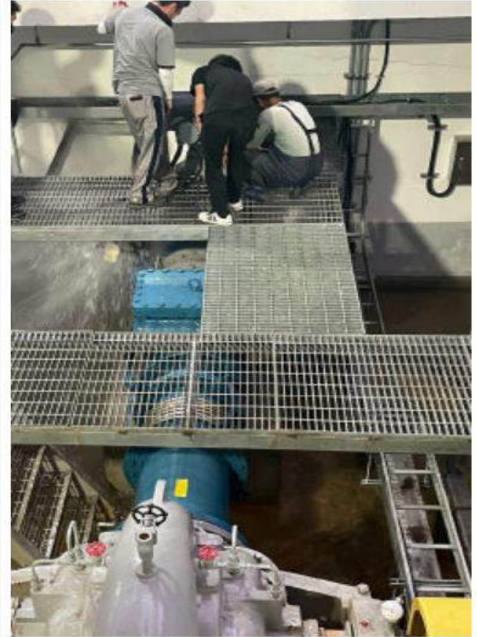
◇춘천시의 수돗물 대란이 소양취수장 취수펌프 밸브 연결부위 파손으로 확인된 가운데 지난 9일 긴급 보수공사가 이뤄지고 있다. 사진=연합뉴스
