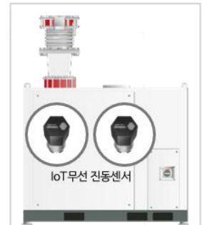
진동센서 (송풍기내 설치)
