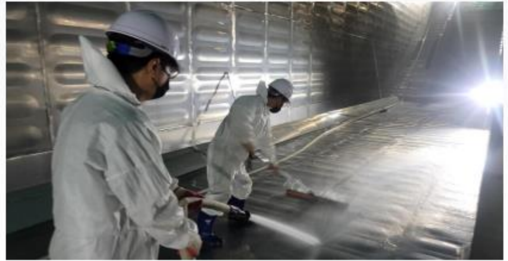
배수지 바닥 물세척 작업
