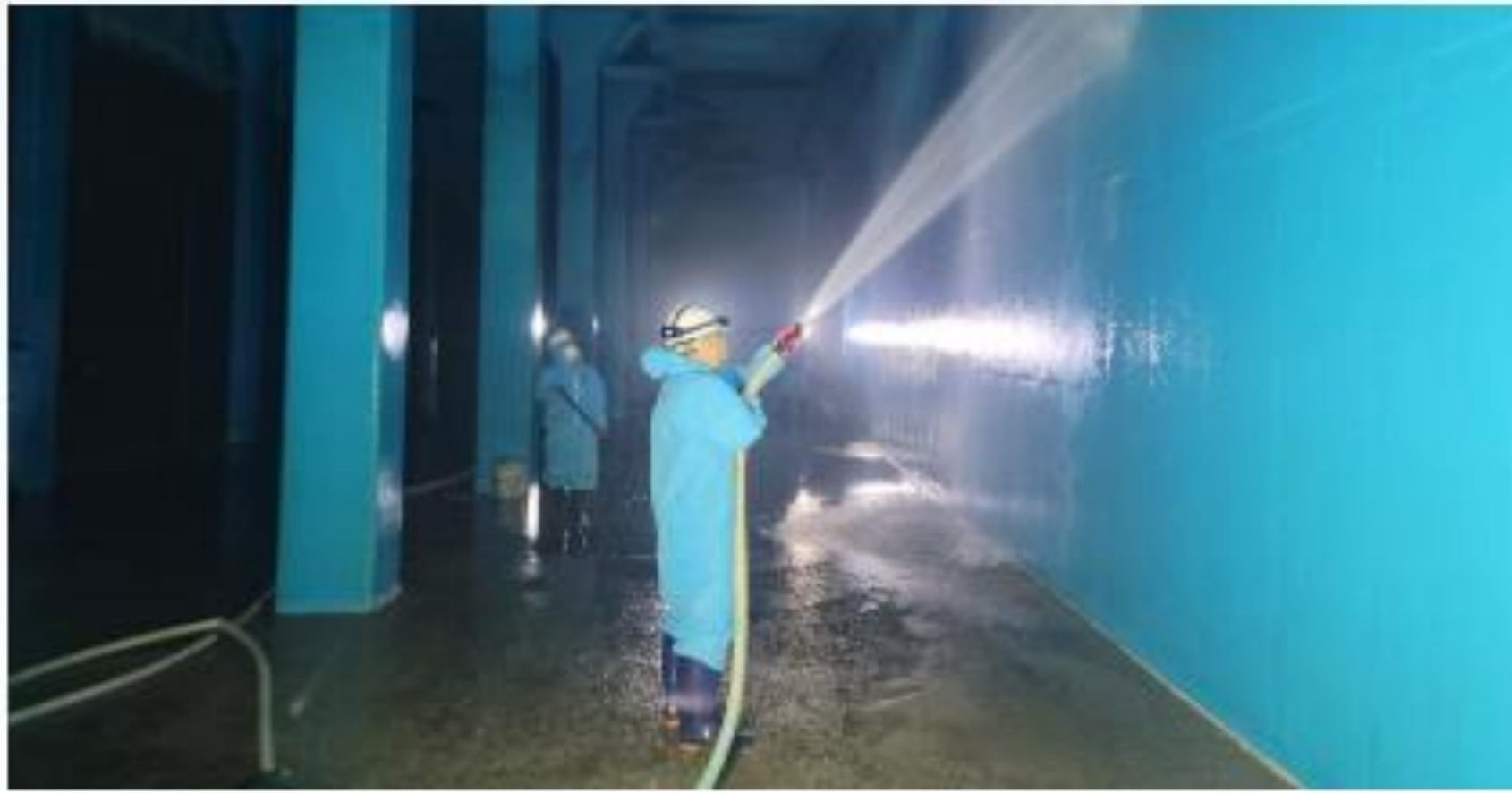
배수지 벽체 물세척 작업
